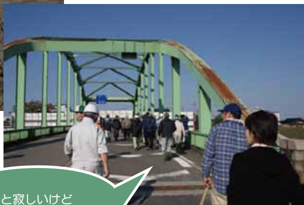
*撤去工事が進められている今町大橋
